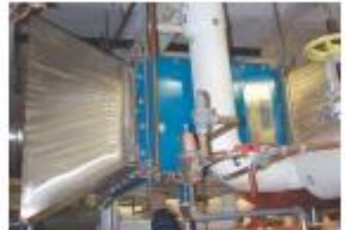
Figure 3 - Économiseur de cheminée installé sur une cheminée d'alimentation de chaudières
