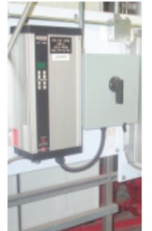
Figure 1 – Panneau de commande de mécanismes d'entraînement classiques à fréquence variable
